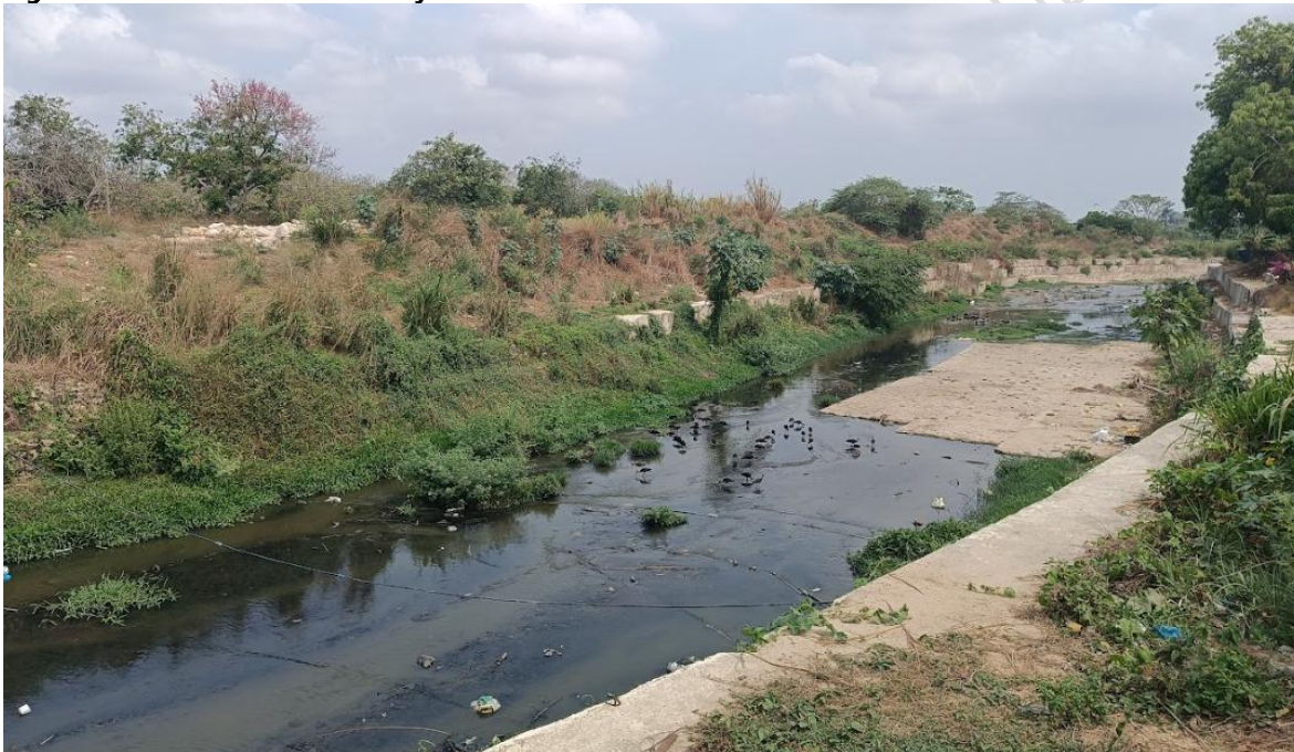
Figura 2.27. Canalización de Arroyo Grande
