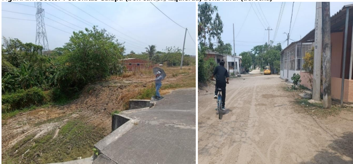
Figura 2.7. Sector Petronitas Galapa (box culvert izquierda) zona rural (derecha)
