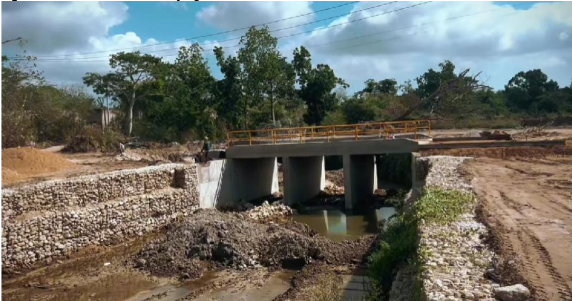
Figura 4.9. Canalización de Arroyo grande en sector Cantilleras
