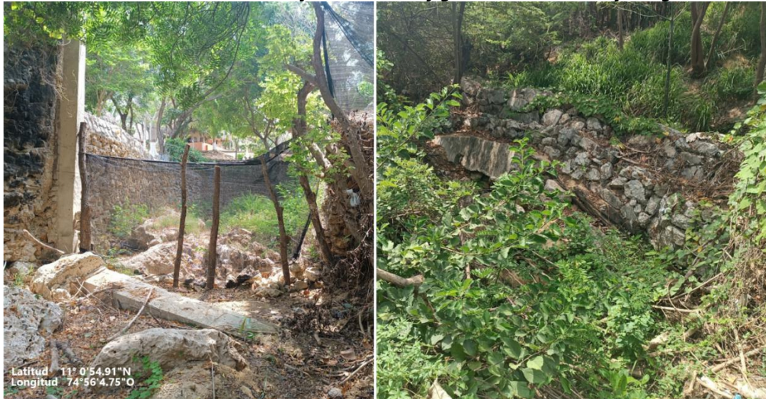
Figura 2.31. Encerramiento de cauce Arroyo San Lorenzo y gaviones Convento Hijas Sagrada Familia
