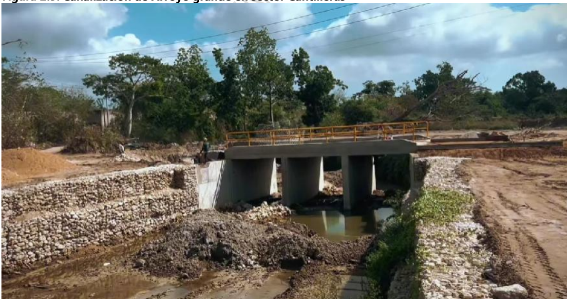
Figura 2.9. Canalización de Arroyo grande en sector Cantilleras
